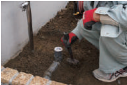
①地面を均します。
