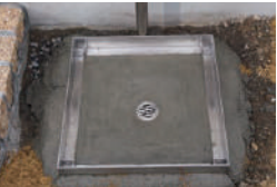
④受枠施工完了。
