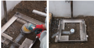
②排水管、受枠のレベルを調整します。
