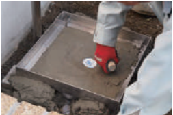
③モルタルで仕上げます。
